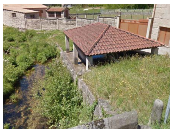
Lavadero en el margen izquierdo, PK 0+810
