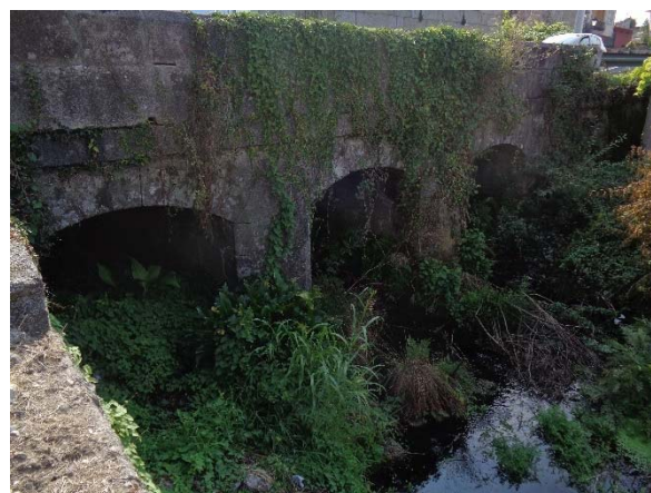
Puente en PK 0+810
